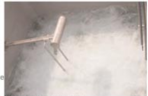
Difusores de tubo en operación
